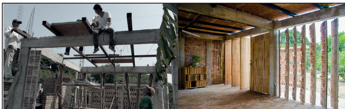
Imagen 4. Proceso de capacitación estudiantes para construcción casa de abuelo a cargo del docente Manuel A. López Hidalgo. Fuente por Archdaily
